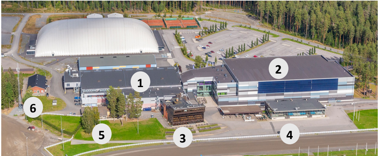
KUVA 3 Suunnittelualan rakennuksia kuvattuna lännestä.
